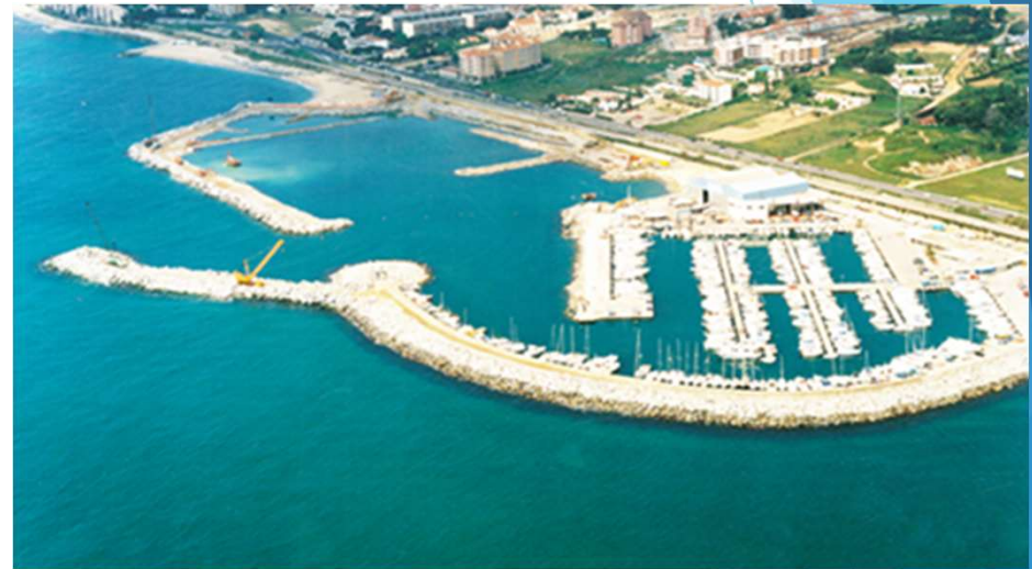
Moll de Garbí construction (SW)
